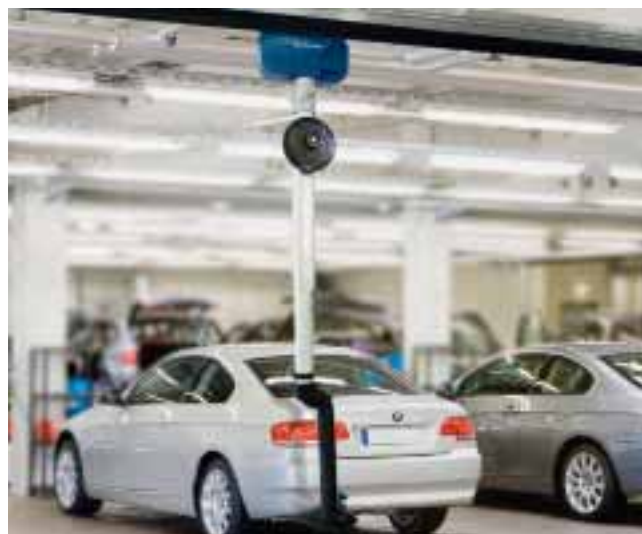
„Bezdotykowa” teleskopowa jednostka odciągowa. Więcej informacji dostępnych jest na naszej stronie internetowej.
